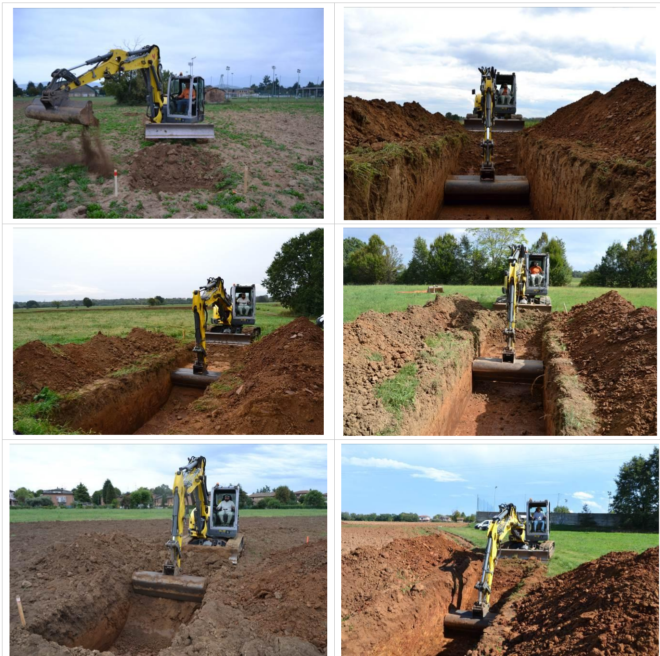
Figura 5 – Fasi di svolgimento dei lavori
